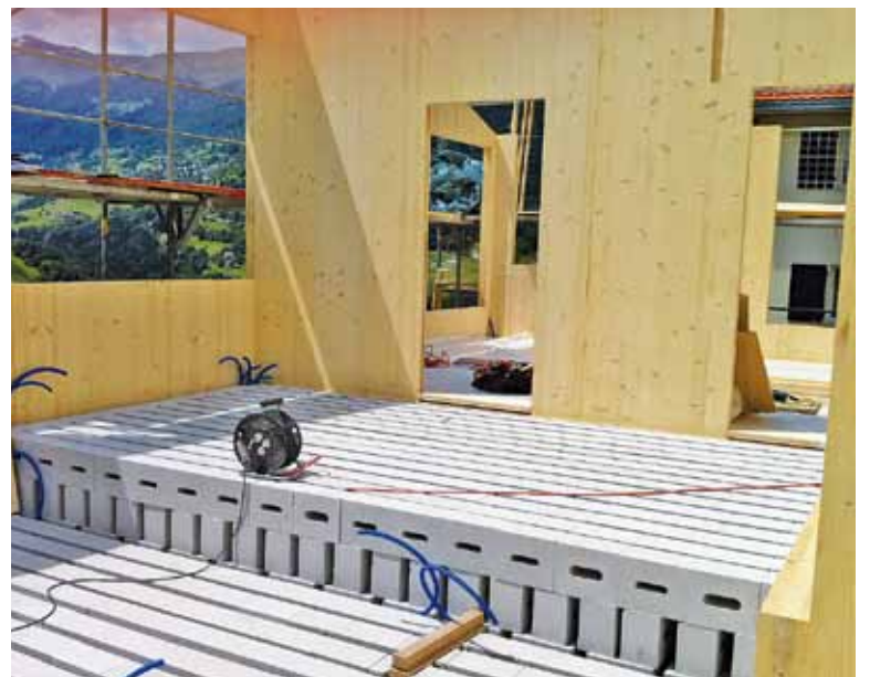
Neben Holz und Beton speichern im Haus von Matthias Stöckli 17 Tonnen Kalksandstein die Wärme aus der Sonnenenergie. Bilder: pd.
