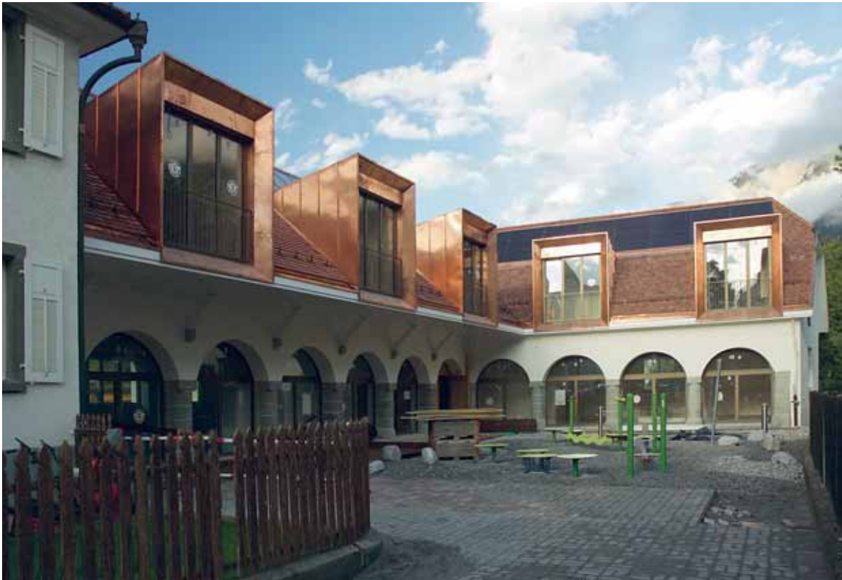
Abbildung 150: Neue, grosse Lukar- nen bringen Licht und Wärme in die Wohnräume im Dachgeschoss.
