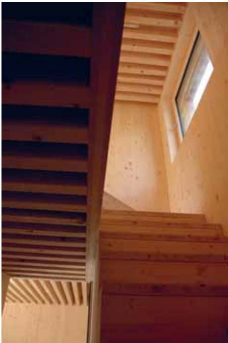
Abbildung 106 (unten rechts): Offene Räume er- möglichen die pas- sive Wärmevertei- lung über die Luft.
